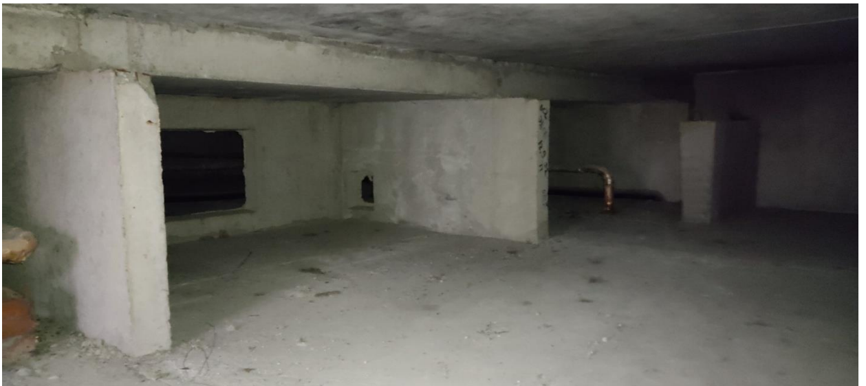
Рисунок 1.6 – Общий вид технического этажа здания в осях Б-Г/6-1
