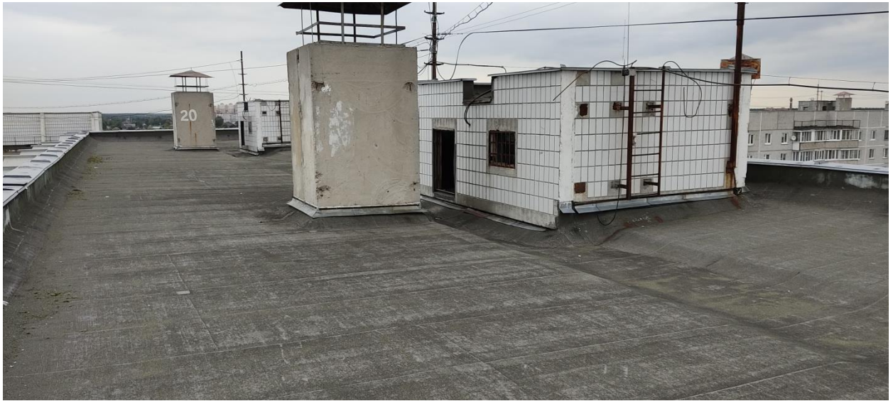
Рисунок 1.5 – Общий вид кровли здания в осях Г-А/1-6
