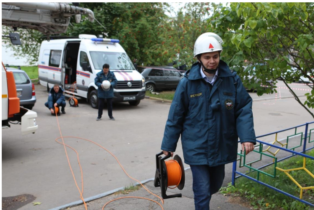
Рисунок 8.1.2 – Динамические испытания здания с помощью мобильного диагностического комплекса «Стрела - П»
